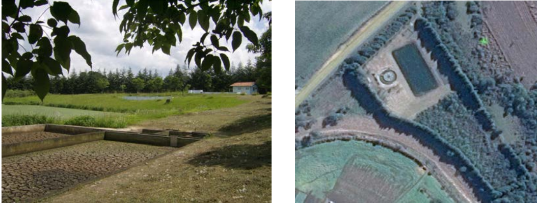
FIGURA 24: ESTAÇÃO DE TRATAMENTO DE ESGOTO DE REBOUÇAS.
