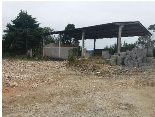
Canil Municipal em construção – Jun 2017
